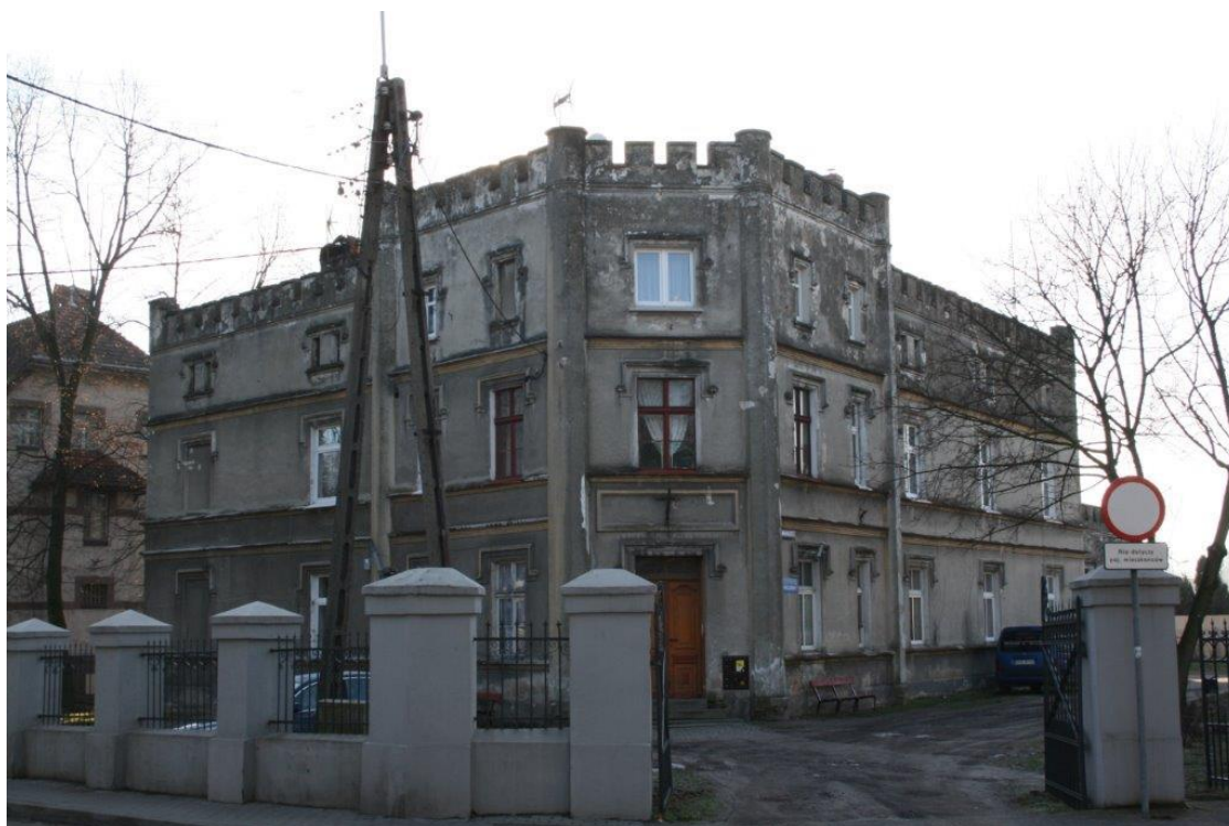
Fot. 8. Budynek zabytkowy przy ul. Wrocławska 1
