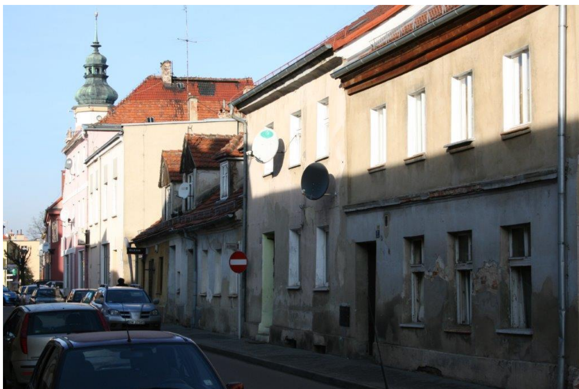
Fot. 7. Elewacje frontowe budynków na ul. Ogrodowej
