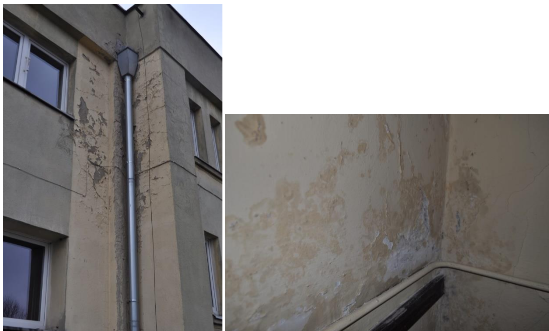
Fot. 3. Elewacja obiektu Domu Kultury oraz ściany klatek schodowych.
