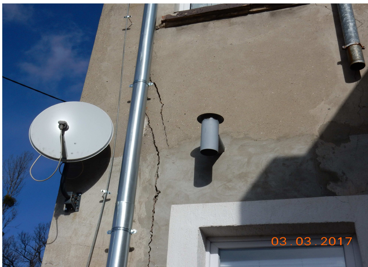
Fot.9 - fragment spękanej ściany frontowej
