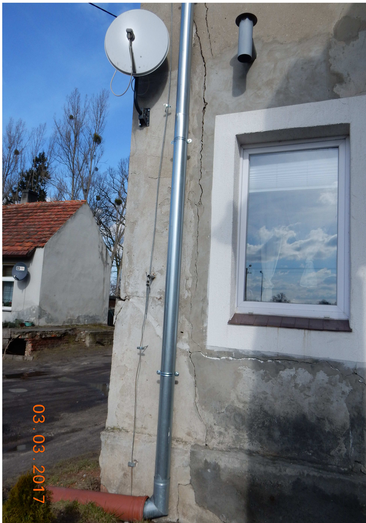
Fot.10 - widok spękannej ściany frontowej
