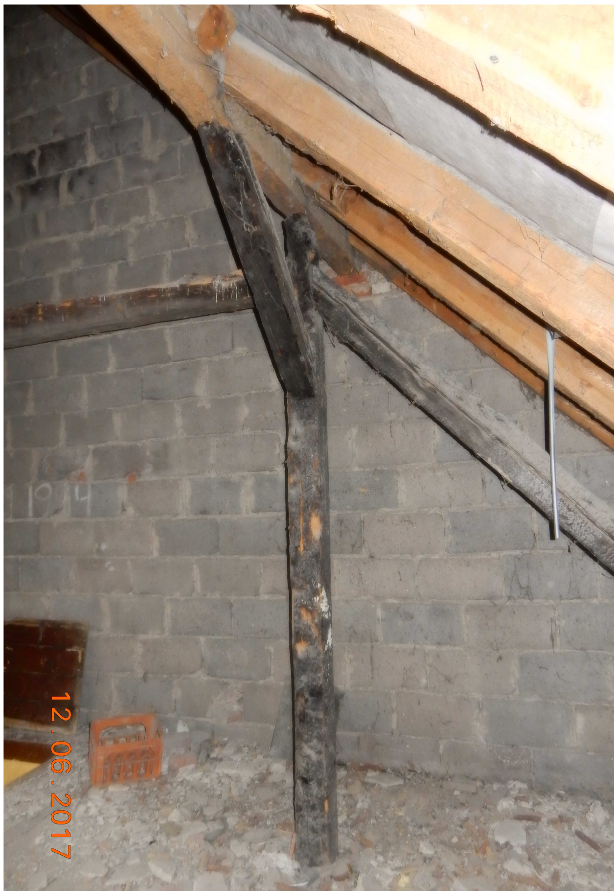
Fot.3 - nadpalone i osłabione elementy więźby dachowej
