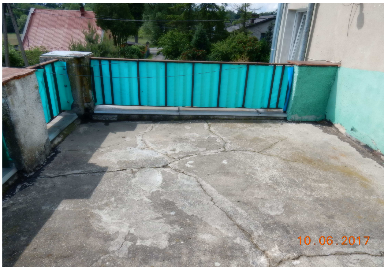
Fot.16 - widok spękaną górnej posadzki tarasu
