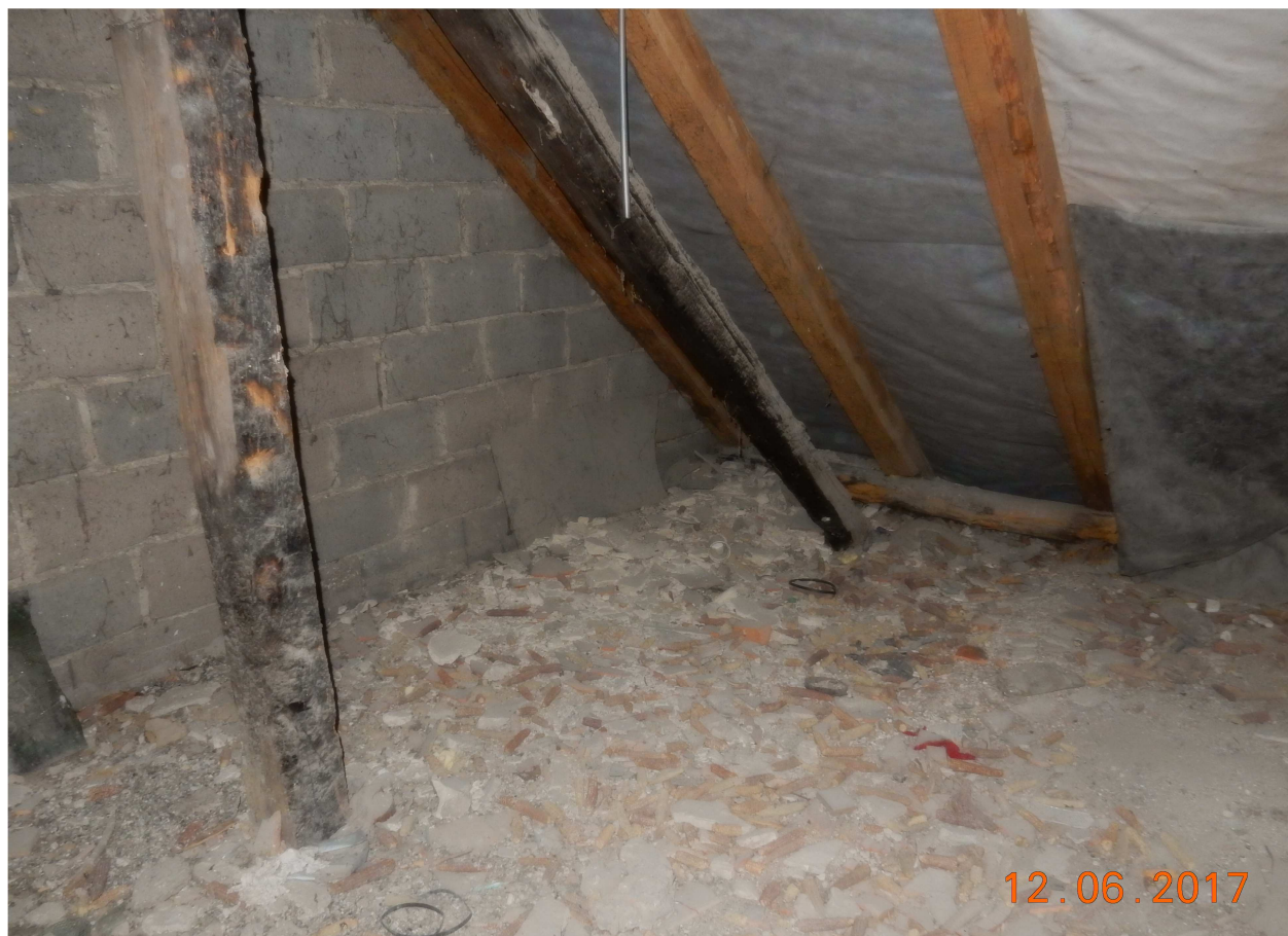
Fot.1 - nadpalone i osłabione elementy więźby dachowej
