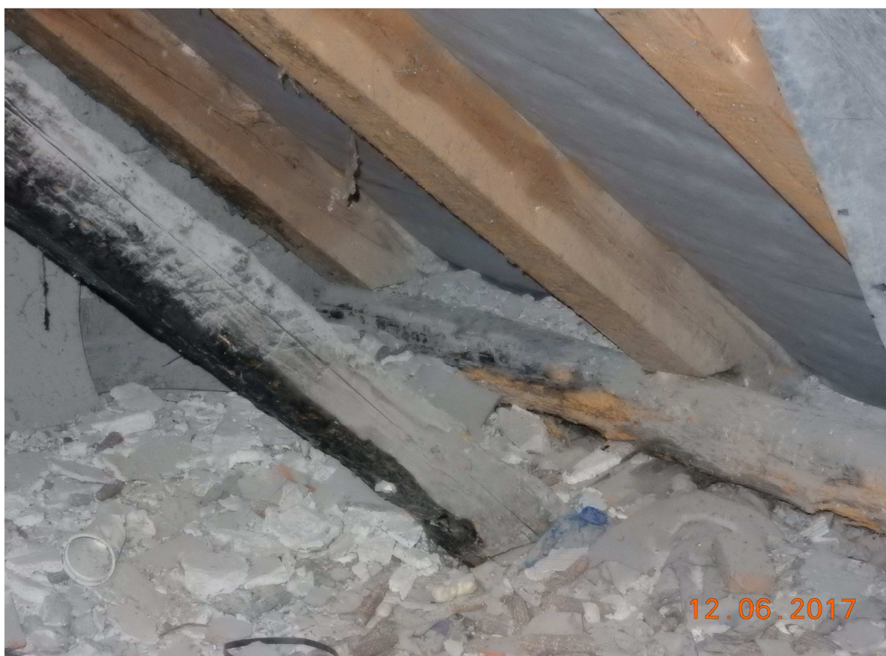
Fot.2 - nadpalone i osłabione elementy więźby dachowej
