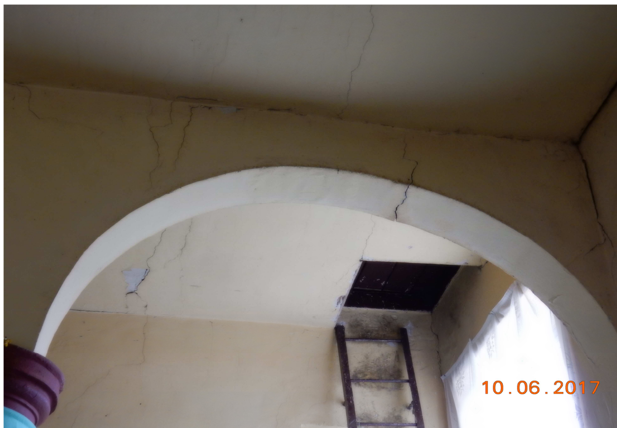
Fot.5 - spękanie nadproże stropu klatki schodowej
