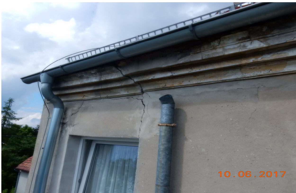
Fot.8 - widok spękanego gzymsu i nadproża ściany frontowej
