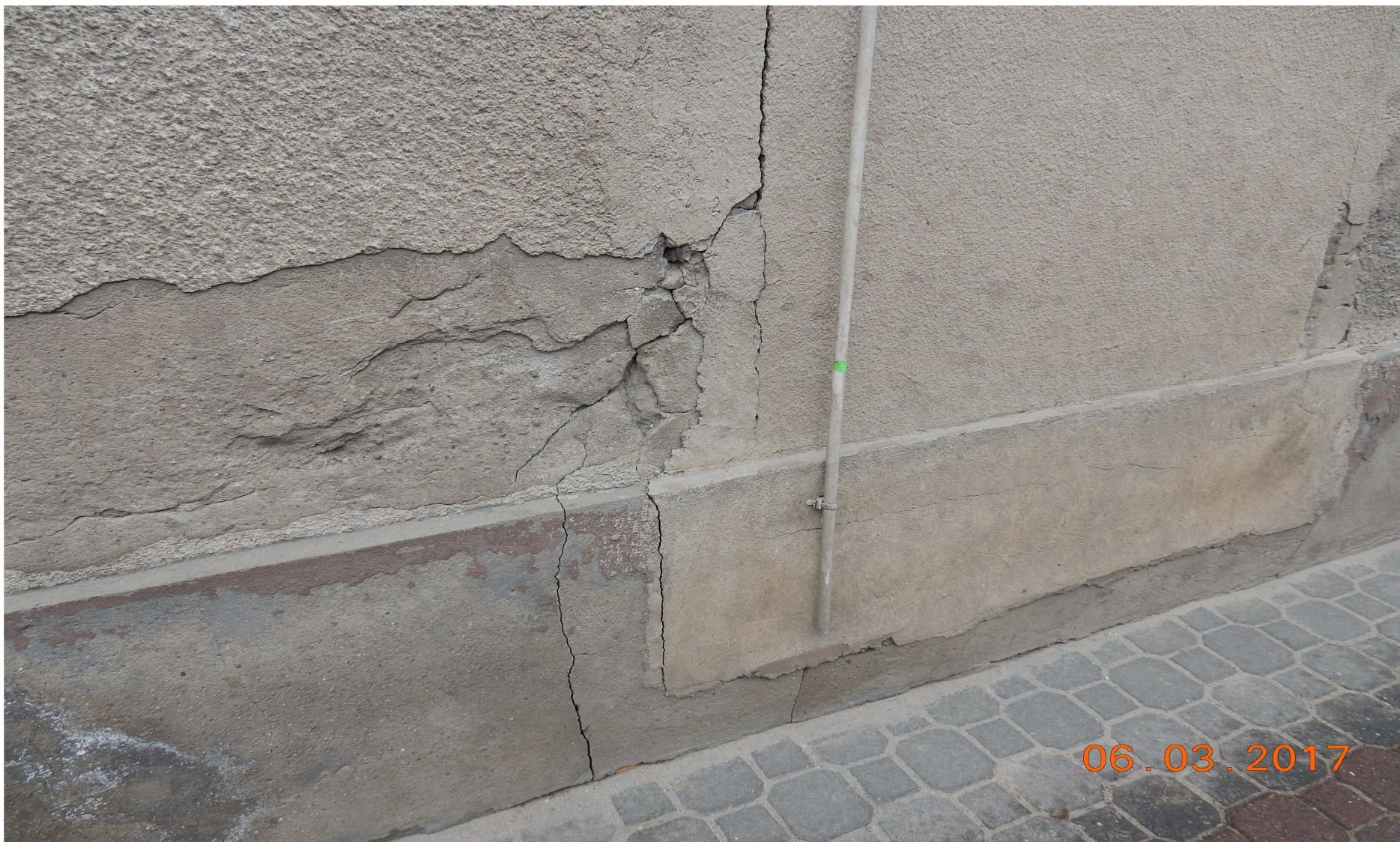
Poz. 8 - widok pęknięcia ściany zewnętrznej od strony ulicy kś. Rudy, jako ciąg dalszy rysy z poz.2, a także widok rysy zamurowanego dawniej otworu drzwiowego z pominięciem wiązania cegieł
