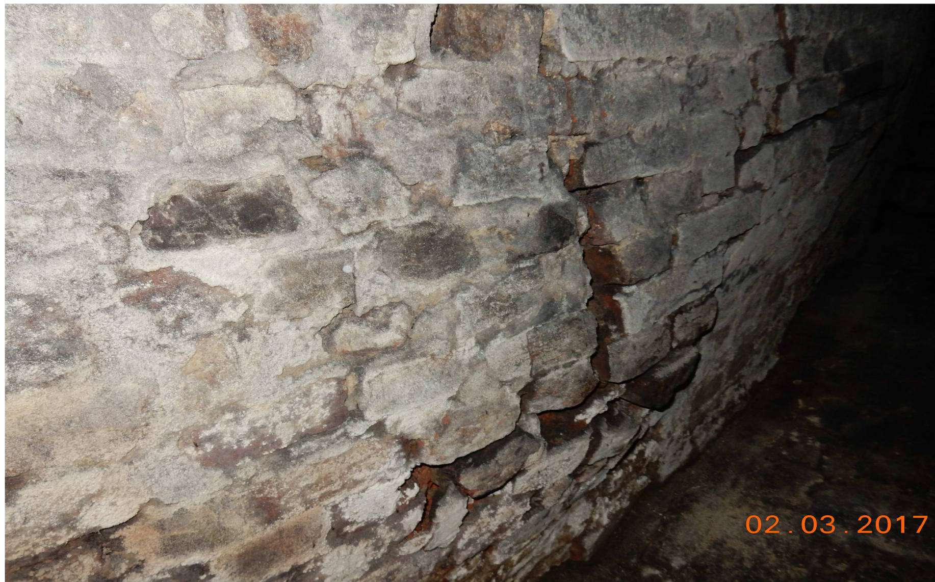
Poz. 3 - korytarz piwnicy, spękana i wybrzuszona ściana wewnętrzna o d strony pom. klatki schodowej /hallu/
