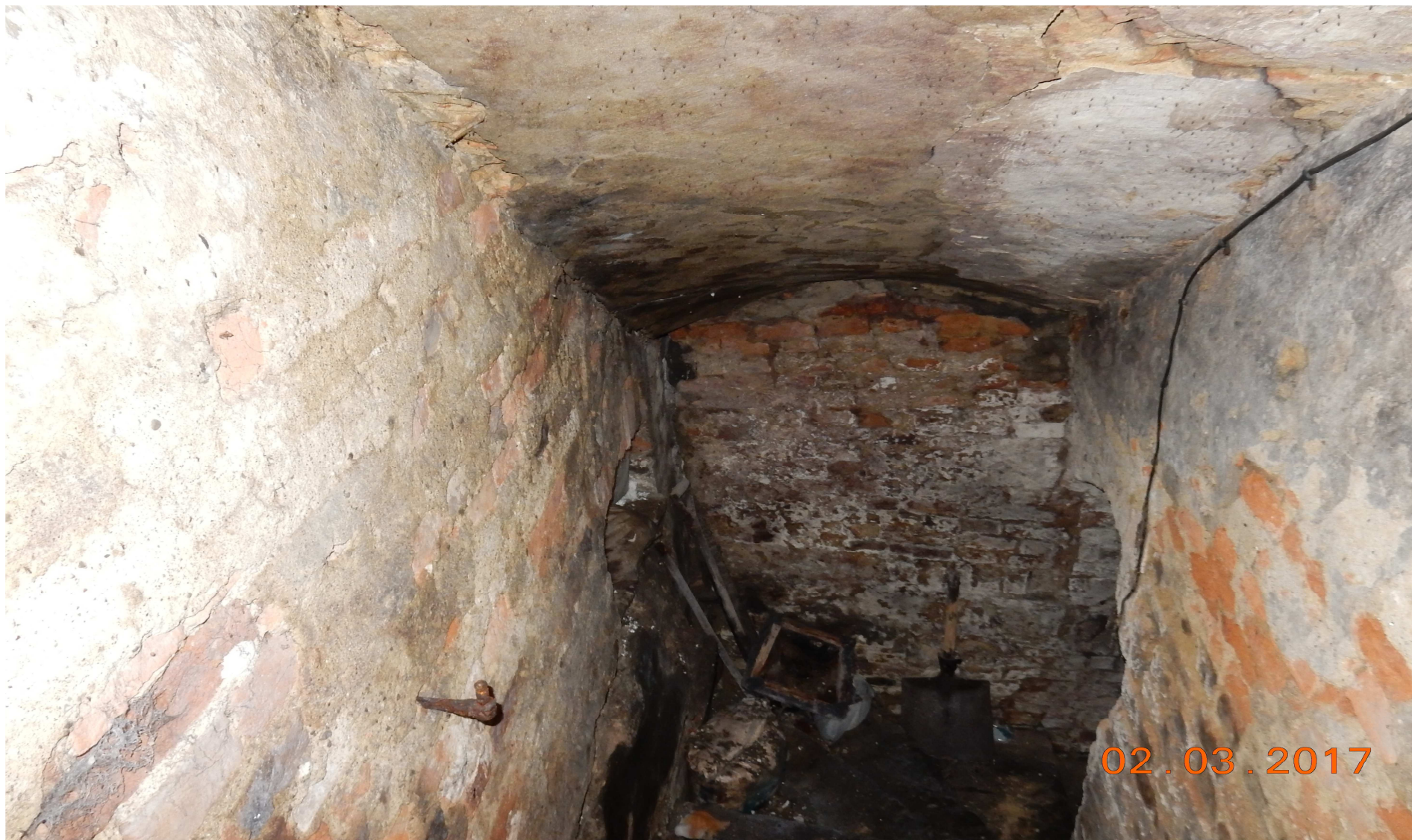
Poz. 2 - zejście do piwnicy, spękana ściana zewnętrzna fundamentowa od strony ulicy kś. Rudy
