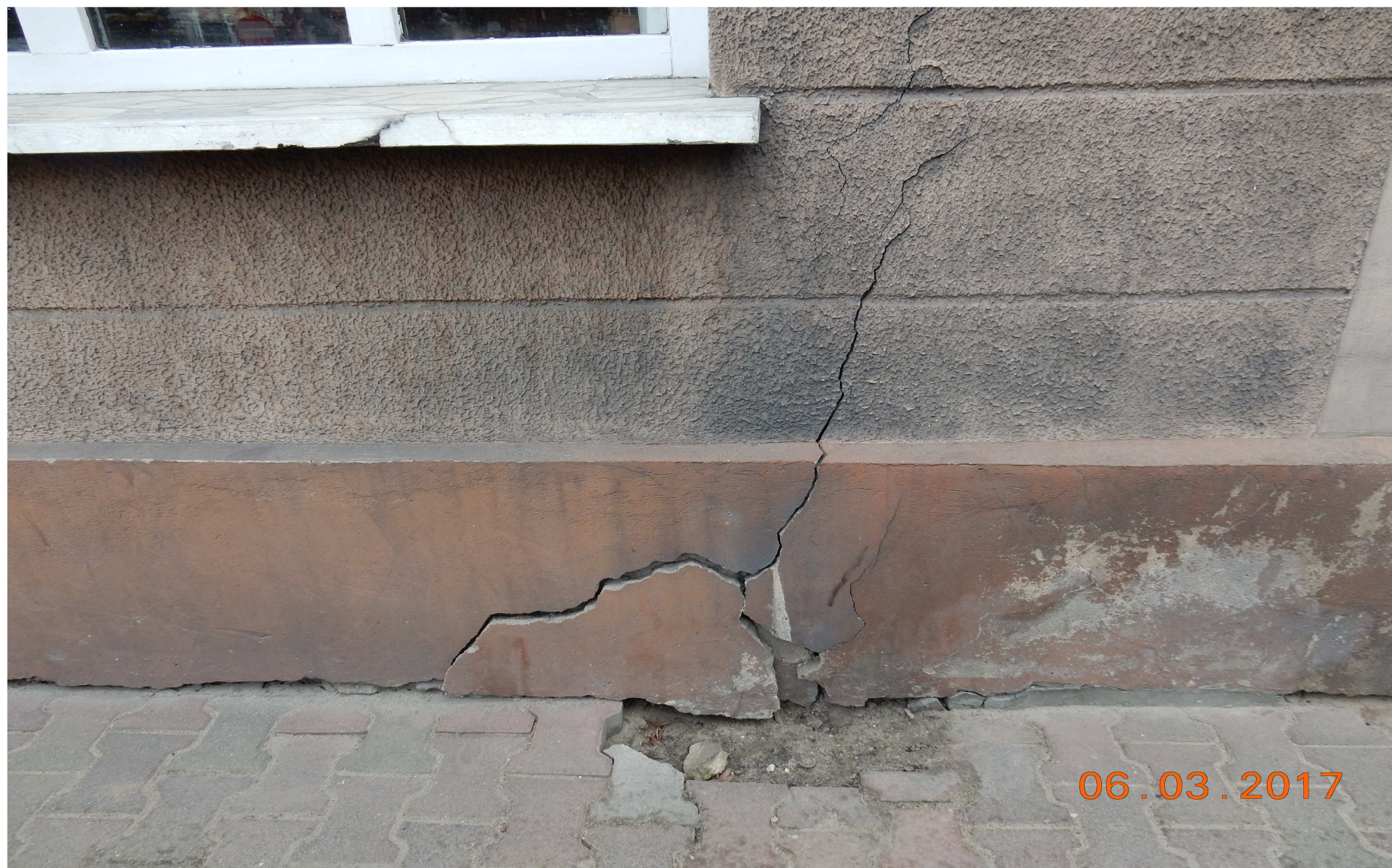
Poz. 5 - widok pęknięcia ściany zewnętrznej niepodpiwniczonej od strony placu Wolności
