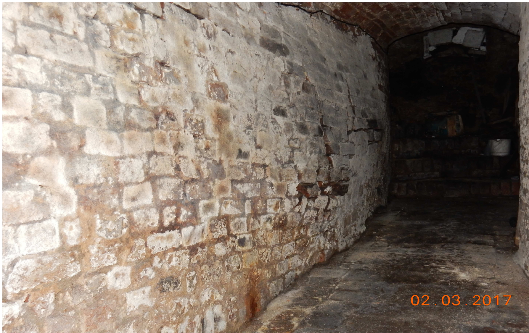
Poz. 3 - widok jw., zauważalna krzywizna wybrzuszenia ściany
