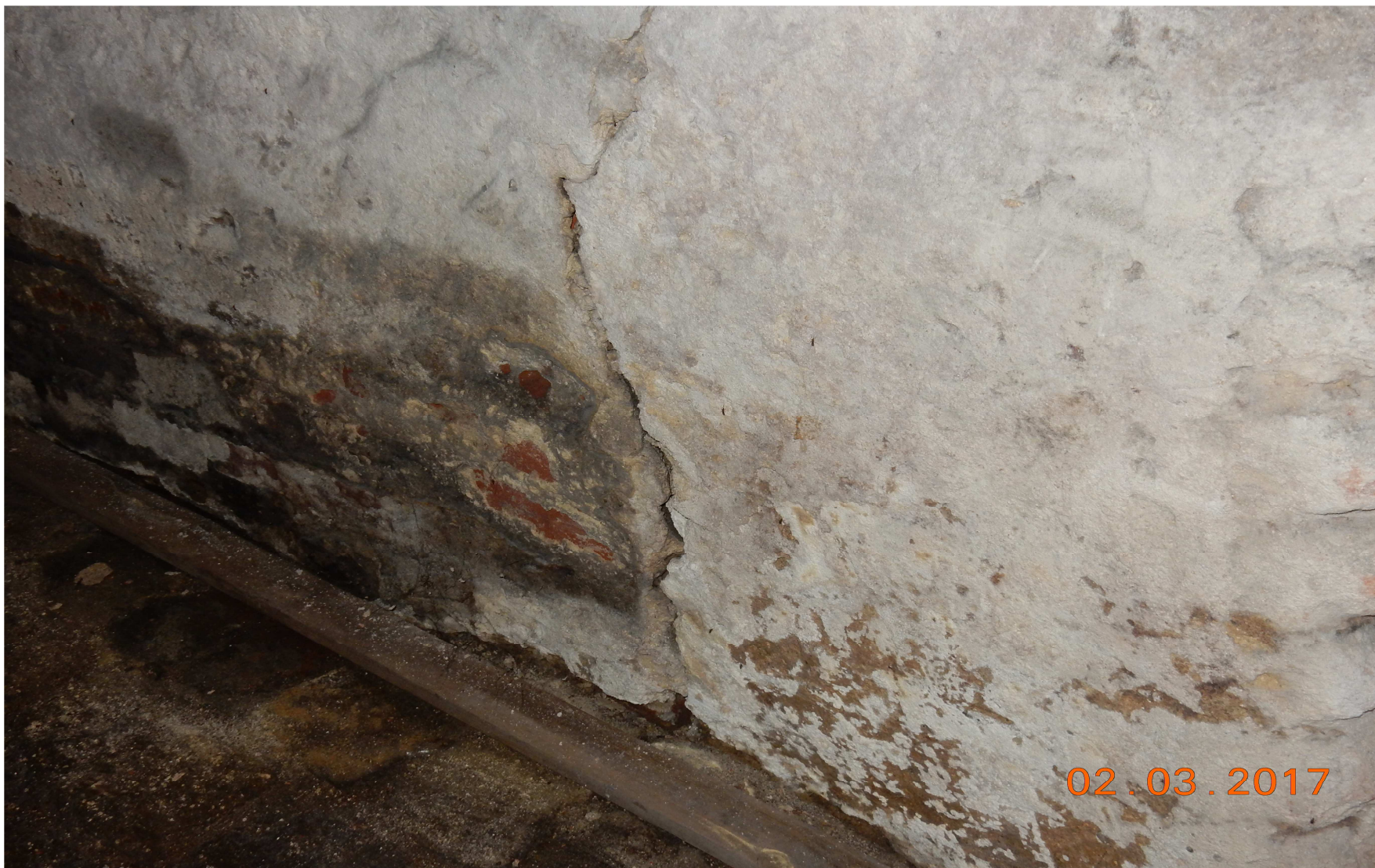
Poz. 4 - widok pęknięcia w ścianie wewnętrznej bocznej piwnicy
