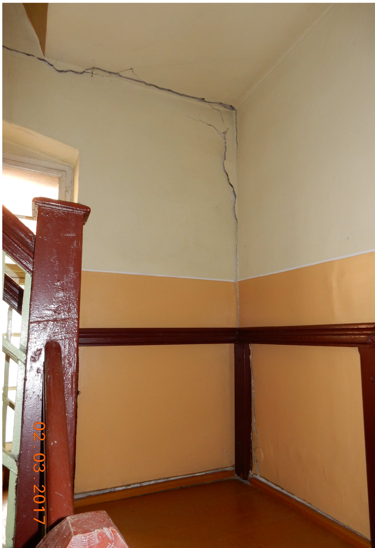
Poz. 1 - widok spękania ściany zewnętrznej klatki schodowej od strony ul. kś. Rudy.
