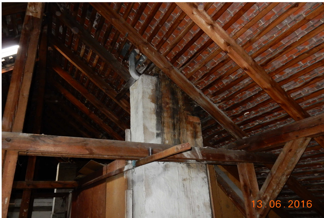
Widok poddasza - „przerwany komin”
