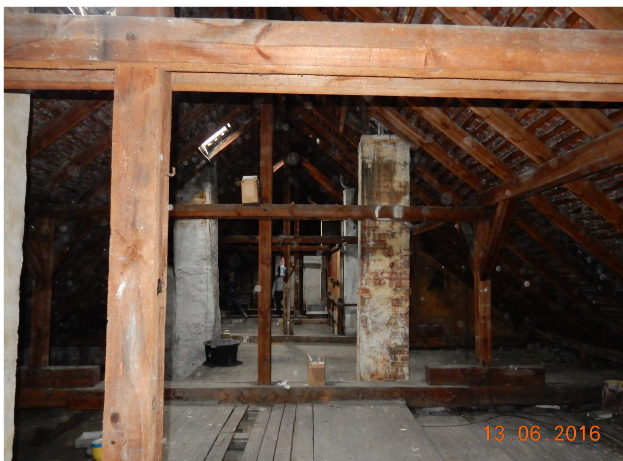
Widok poddasza – kolejny „przerwany komin”
