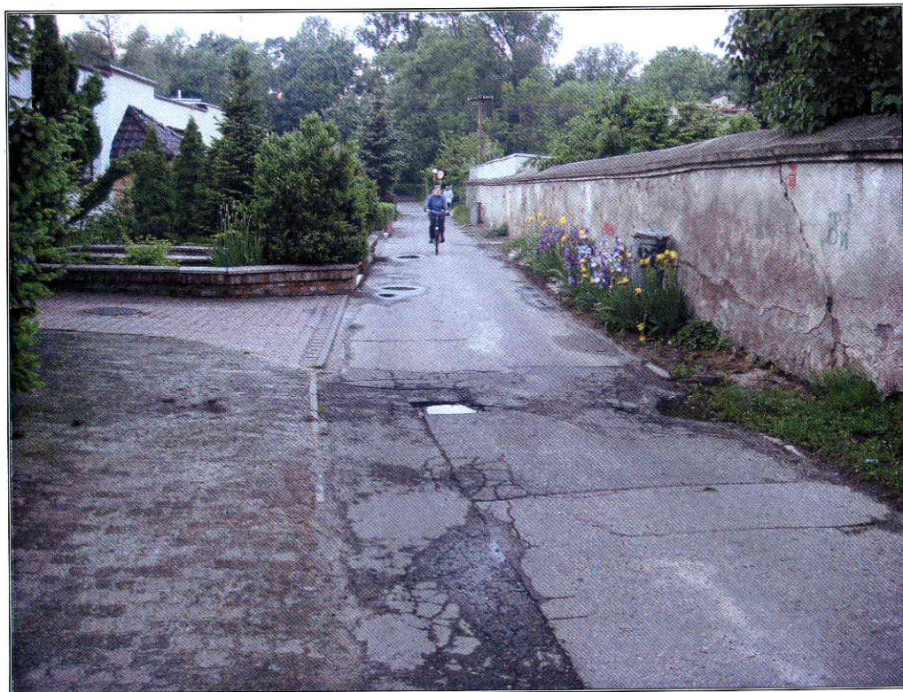
Rysunek 8 - uszkodzenia i nierówności przy zabudowie mieszkaniowej
