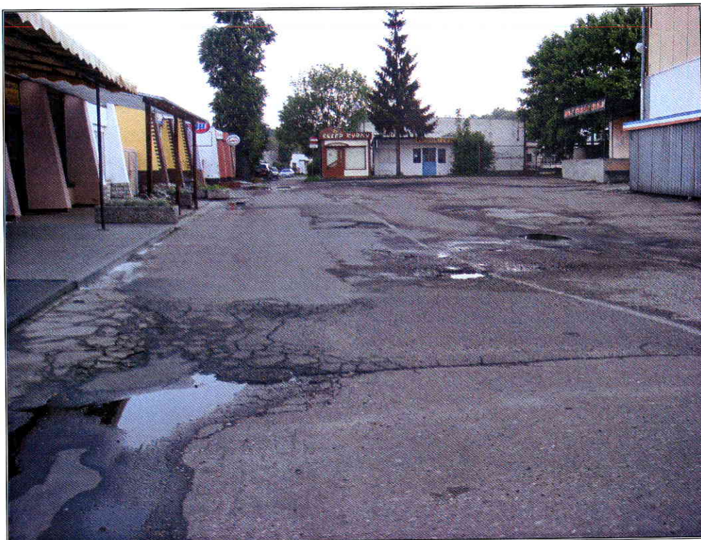
Rysunek 3 - widoczne zaniżenie poziomu nawierzchni
