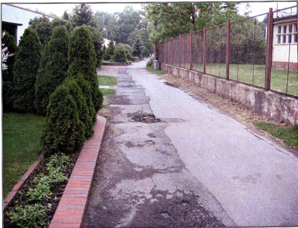
Rysunek 7 - uszkodzona nawierzchnia przy zabudowie mieszkaniowej
