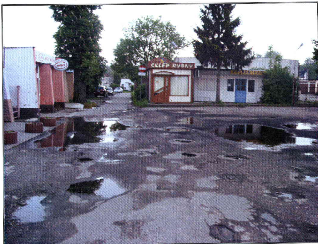
Rysunek 4 - uszkodzenia i nierówności istn. nawierzchni
